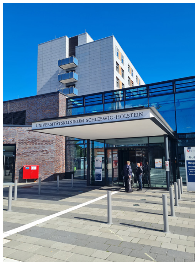
Obr. 2. Vstup do Universitätsklinikum Schleswig-Holstein (UKSH) v Kielu
